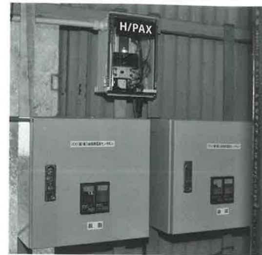
写真3 HIPAX IIのコントローラ。下のボックスが1世代前の有線タイプ、上が現行の無線タイプ
